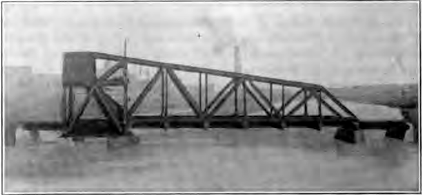
FIG. 30b. Scherzer Bascule Bridge.
